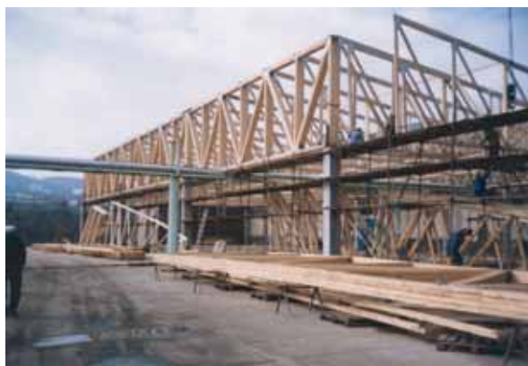
Obr. 11: Zastřešení průmyslové haly
