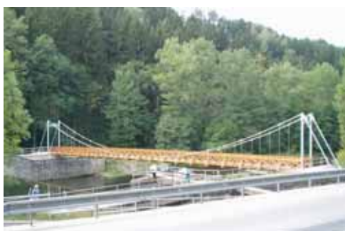
Obr. 20: Lávka v Benešově u Semil
