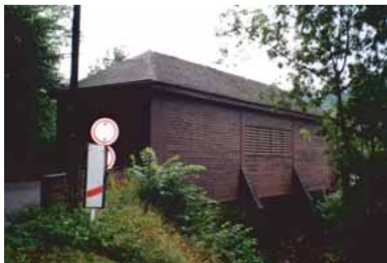
Obr. 16: Silniční most z roku 1840 přes říčku Zdobnici u osady Peklo
