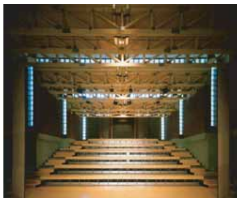
Obr. 10: Konstrukce zastřešení divadla Alfred v Praze
