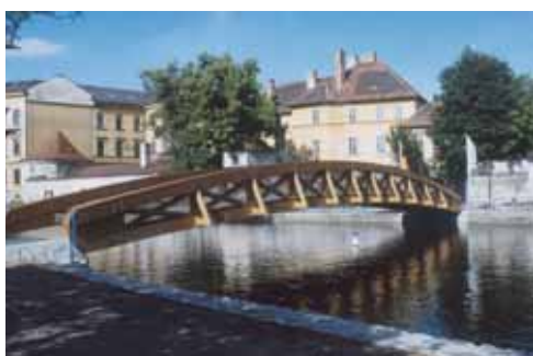
Obr. 19: Lávka v Českých Budějovicích
