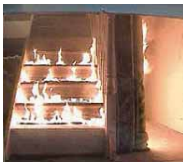
Obr. 8: Schodiště objektu při požáru
