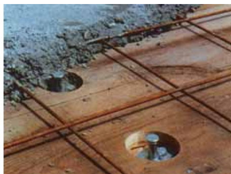
Obr. 13: Příklad provedení kompozitního dřevobetonového stropu
