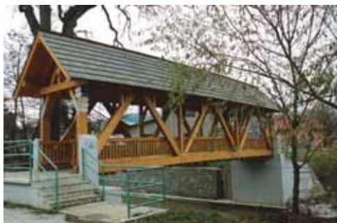
Obr. 18: Lávka ve Vikýřovicích
