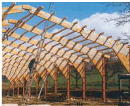
Obr. 9: Konstrukce s dřevěnými trámovými rošty
